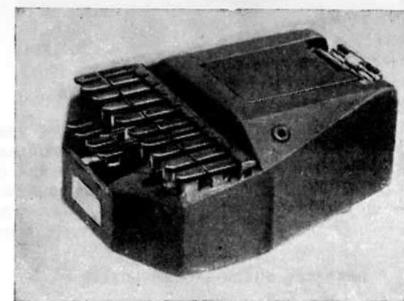
Рис. 1. Стенографическая машина STM-2
