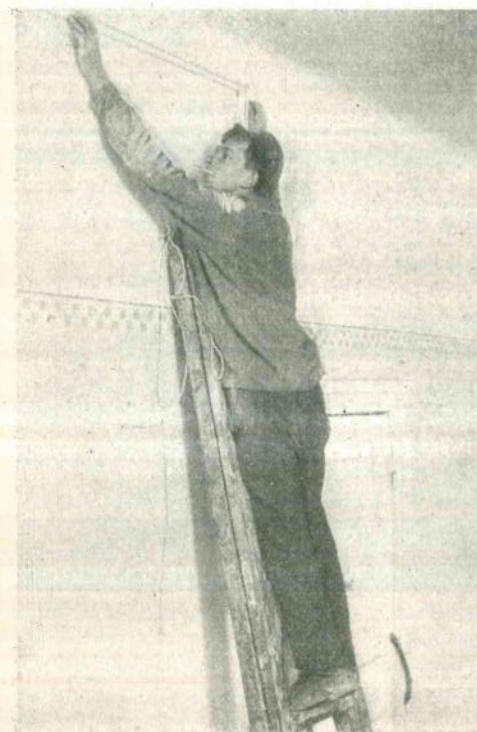
Электропроводка предшествует обивке.
